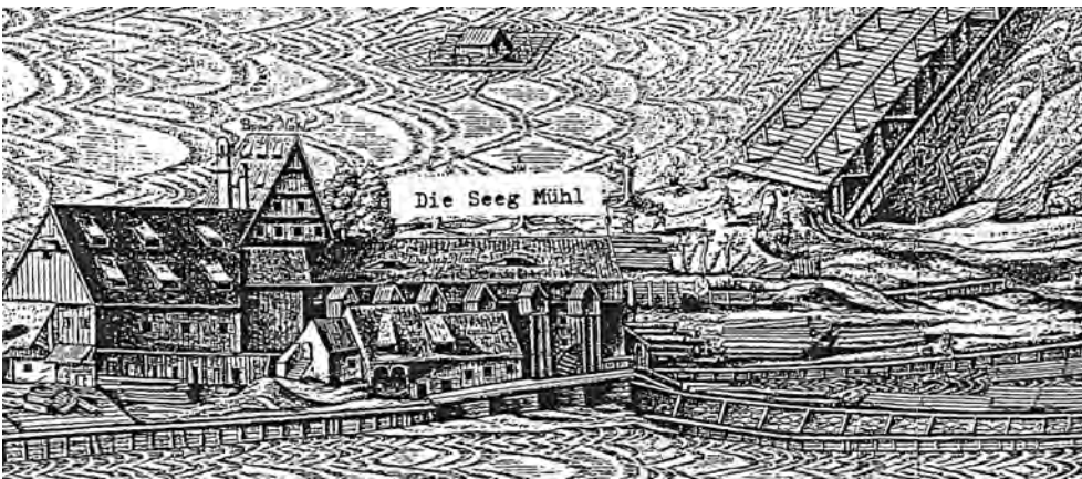
Bild 8: Regensburg um 1600, Obere Wöhrd, Mühlenkomplex mit mehrgängiger Säge, Papiermühle und Hammer, 1638 Georg Bahre. Beschreibung p. Germann-Bauer 10) 1999; S. 93: das Gebäude umfaßte mehrere Mühlwerke; Säge um 1522 errichtet; erst ein Gang, bald ein zweiter und dritter Gang; 1557 Erneuerung mit vier Gängen; 1580 wird Furniermühle eingerichtet, „... daran man den Schreibern edl und ander holtz zum fuernieren khan schneiden ... Hat vorhin khaine alhie gehabt“.
